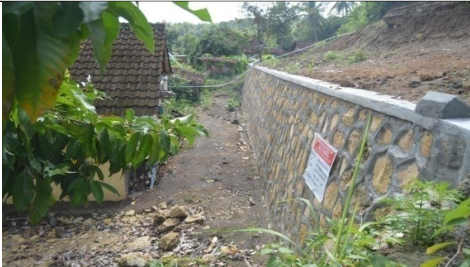
Foto 0% Talud Jalan Dusun Jembul Rt 001/004
