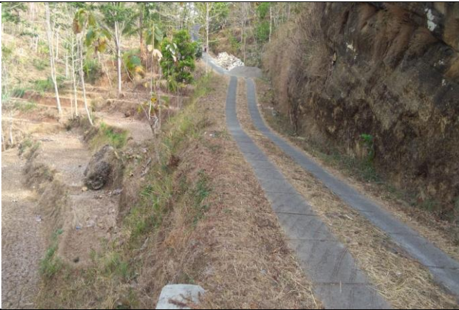
Foto 50% Talud Jalan Dusun Jembul Rt 001/004
