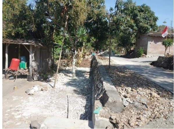
FOTO 100% Talud Jalan Dsn Jati RT002/05
