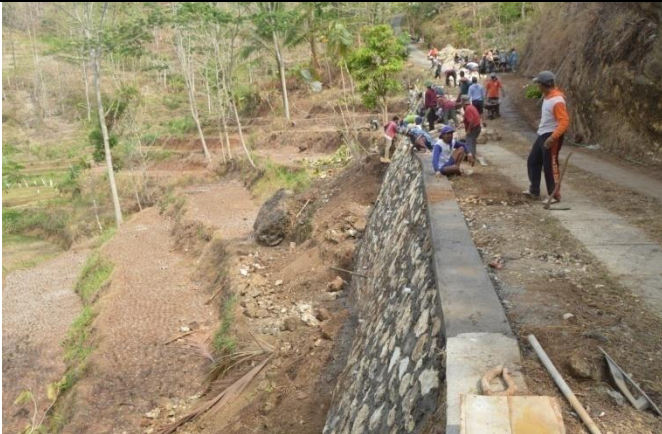
Foto 100% Talud Jalan Dusun Jembul Rt 001/004
