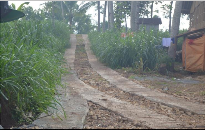
FOTO 0% TALUD JLN DSN SUMBERWATU Rt 001/013
