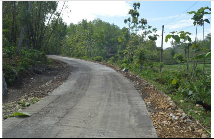
Foto 0% Talud Beji Rt 002/012
