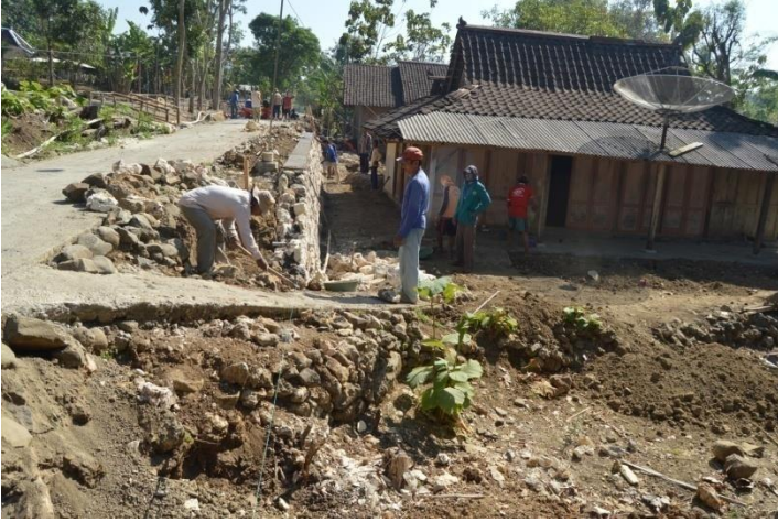
Foto 50% Pembangunan Talud Jalan Dsn Beji
